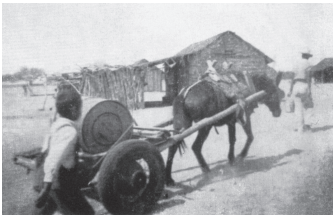
Carreta en la que se llevaba agua para las construcciones de casas. Marzo de 1942.
