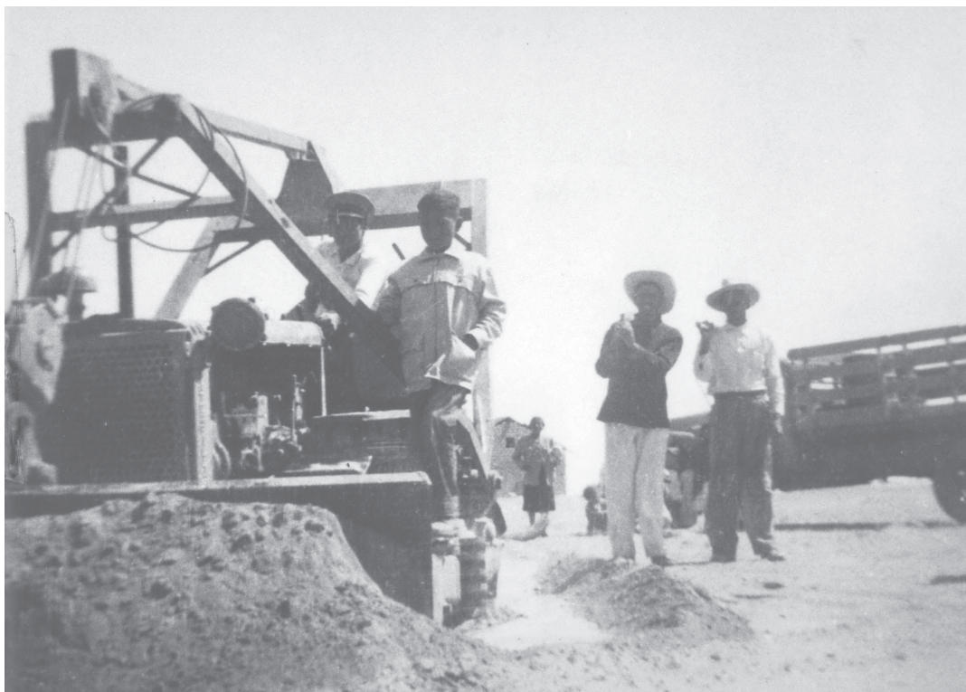
Tractor Caterpillar R-4, 1951, excedente de la Segunda Guerra Mundial. Según los mecánicos del gobierno del Territorio Sur de la Baja California, esta máquina tenía impactos de bala en algunas partes y fue necesario cambiar algunas piezas, como el tanque de diesel, al traerlo a María Auxiliadora.
