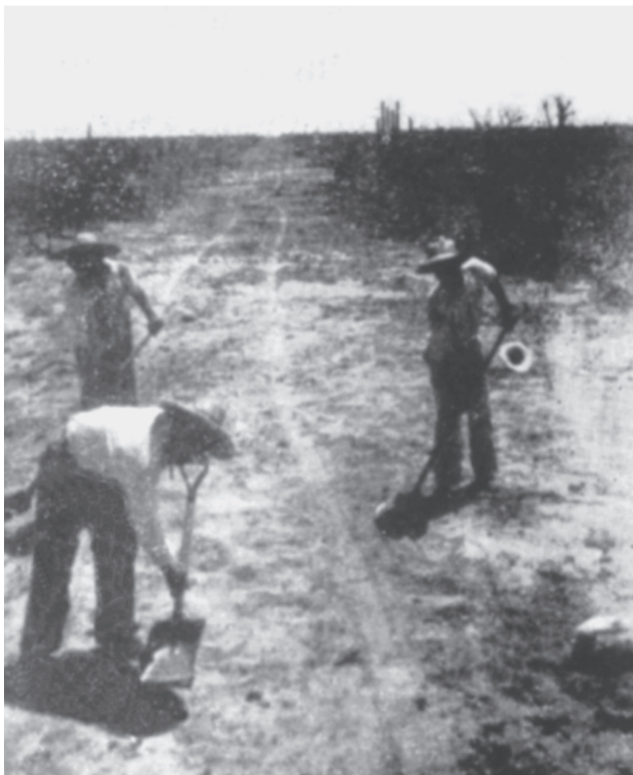
Abriendo la brecha para la carretera a San Francisco Javier y Loreto. Mayo de 1942.
