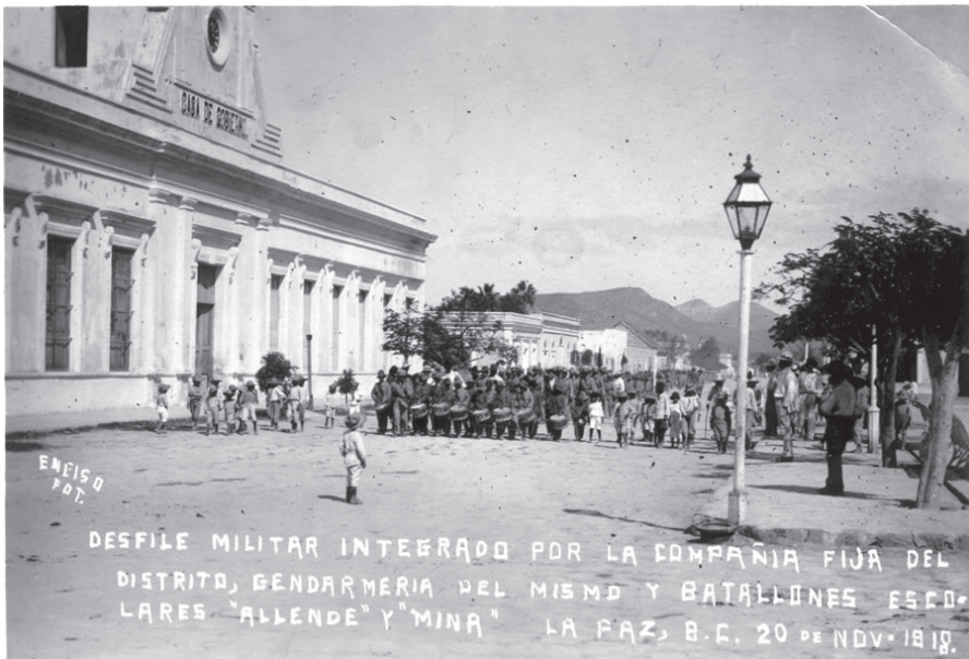
Casa de gobierno. Se aprecia ya el alumbrado público (AHPLM).
