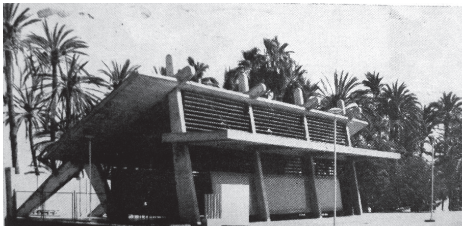
Depósito de bombeo de aguas negras (AGEBCS).
