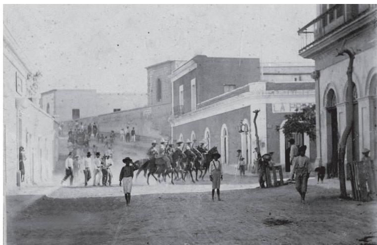
Construcciones en La Paz (AHPLM).
