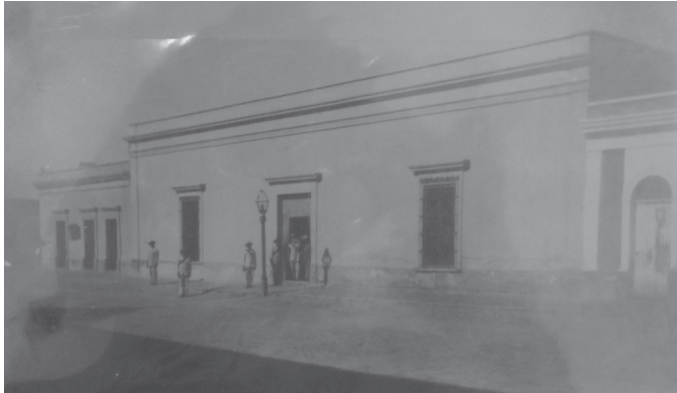
Fachada de la cárcel de la ciudad de La Paz (AHPLM).
