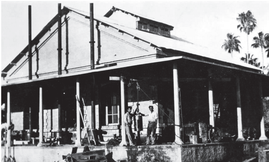
Planta eléctrica de La Paz, 1936 (AHPLM).
